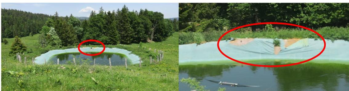
L'étang artificiel Pré Meunier (appelé également étang ou réservoir E1) a une capacité de 180m<sup>3</sup> et alimente le chalet Devant des Fruitières. Aujourd'hui en très mauvais état et percé, il ne remplit plus son rôle d'alimentation des bassins et abreuvoirs de l'exploitation. Avec les épisodes de sécheresse de plus en plus fréquents, son remplissage n'est également plus garanti ni suffisant
