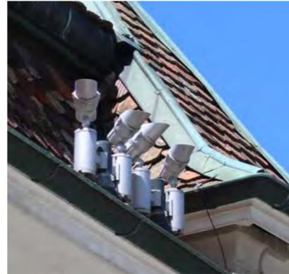
**Principe :** éclairage des façades du château par projecteurs placés sur les façades ou posés au sol et par des encastrés de sol.
