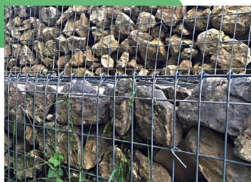
Gabion en pierres sèches
