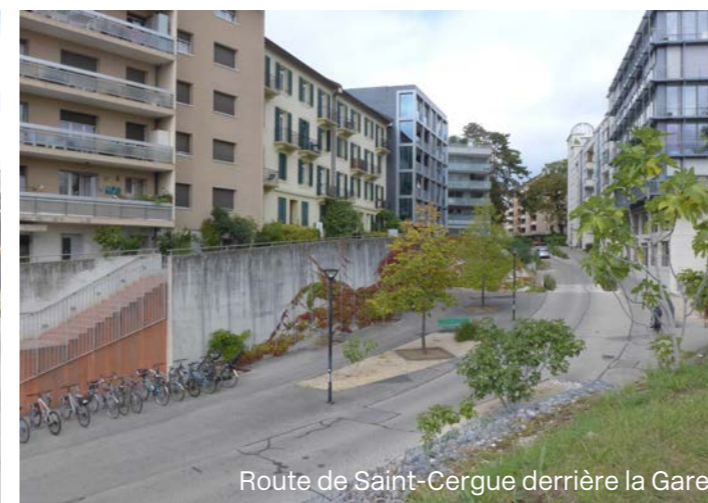
Passage sous-voies de la Gare
